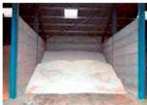
Coût de stockage en cases pour une capacité de 150 tonnes (500 tonnes) : deux (quatre) cases de 75 tonnes (125 tonnes) chacune, sur une dalle de béton standard. Les parois sont en béton banché. Chaque case est équi-
